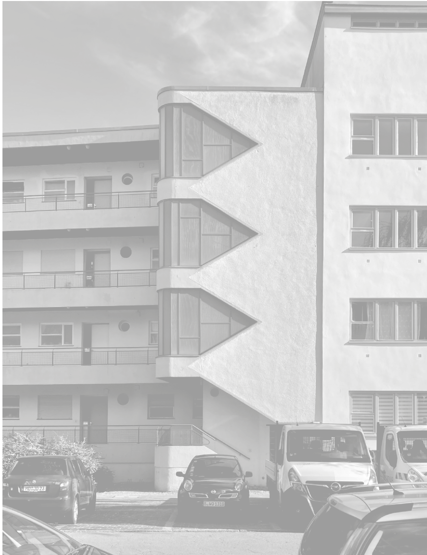
Immeuble de logement avec coursives, Siedlung Siemensstadt, Berlin-Charlottenburg, 1955-1956 ©Emmanuel Cros, 2025 Laubenganghaus Goebelstrasse, Siedlung Siemensstadt, Berlin-Charlottenburg, 1955-1956 ©Emmanuel Cros, 2025
